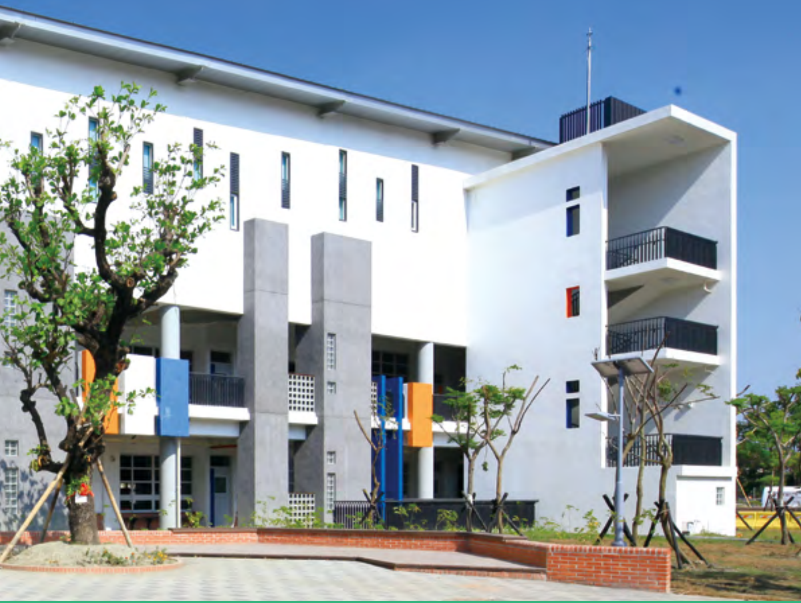
●主建物正立面
